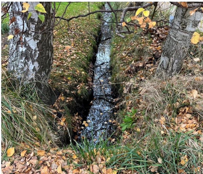
Figur 5.4: Vandfyldt grøft, Dortheavej
